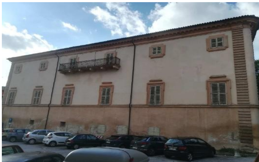
Fronte dell'edificio verso la prospiciente piazza
