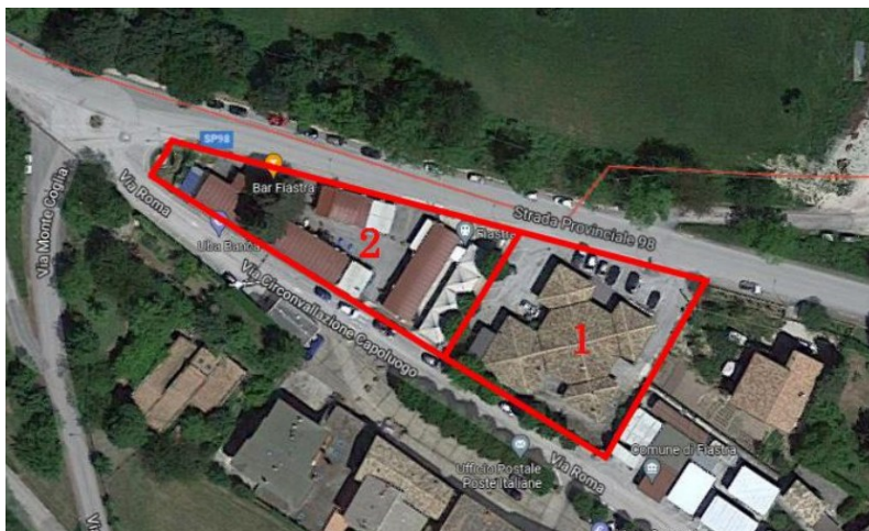
Fig. 1 - Stato di fatto dell'area oggetto di ricostruzione della nuova area commerciale, nella “zona 1” è evidenziato l'attuale edificio commerciale comunale, nella “zona 2” i moduli provvisori che ospitano temporaneamente le attività commerciali.
